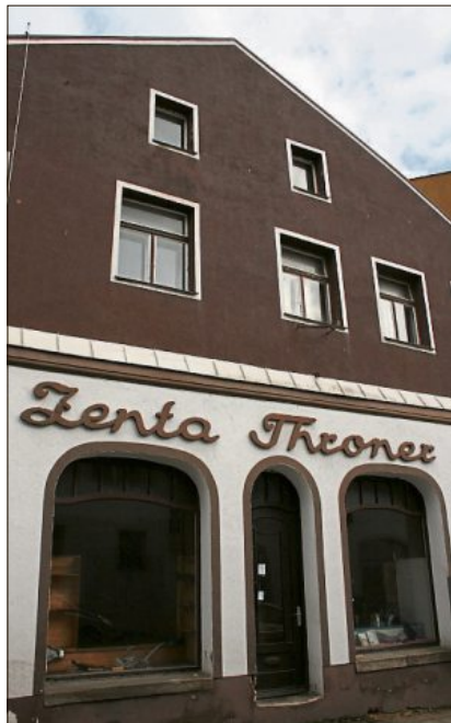
Erst Wirtshaus, dann Geschäftshaus und bald Bürokomplex.
