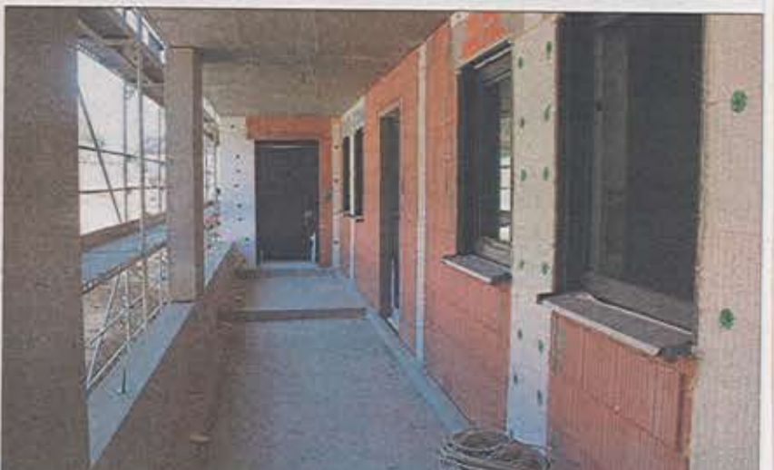
Über Laubengänge sind die Wohnungen zu erreichen.
