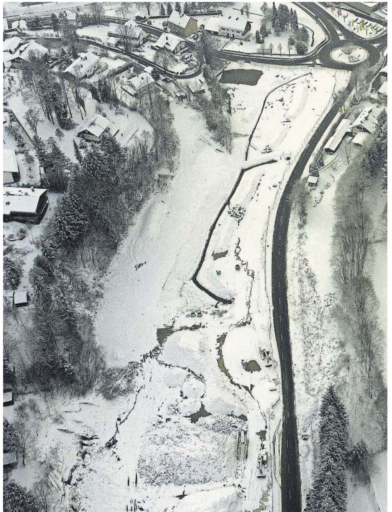
Die Westumgehung ist seit Wochen gesperrt, obwohl zumindest gefühlt „nichts geht“ auf der Großbaustelle. Investor Matthias Altmann erklärt, woran das liegt.
