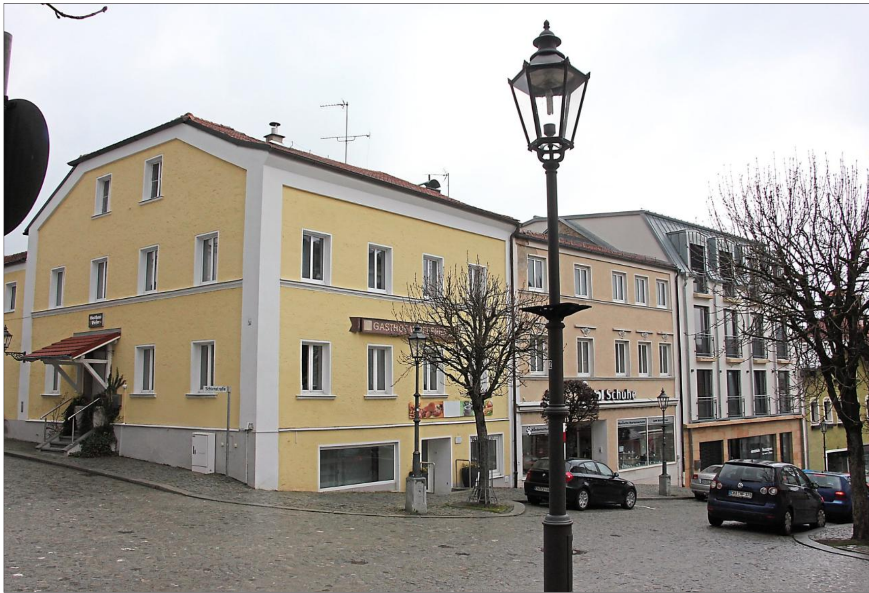
Das Gasthaus Pfeffer und das Schuhgeschäft Liebl sollen abgerisse. An der Stelle soll ein fünfstöckiger Neubau entstehen.
