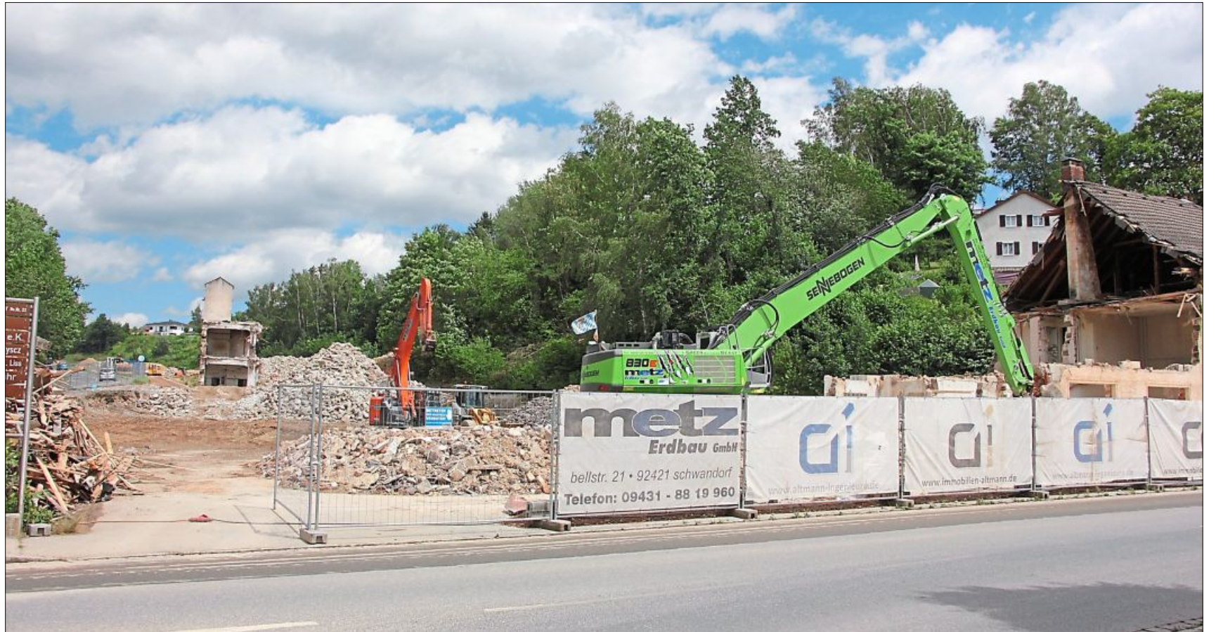
Seit Januar finden am Aschenbrenner-Areal Abbrucharbeiten statt.
