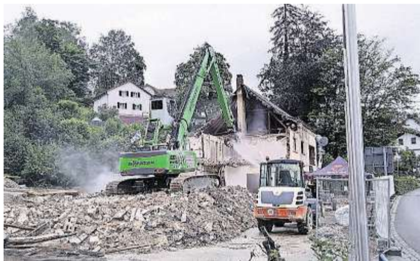
Die Abrissarbeiten sind in diesen Tagen an den letzten Gebäuden der ehemaligen Firma Aschenbrenner angekommen. FOTO: S. WEBER
