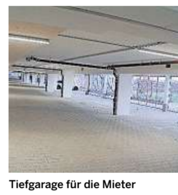
Tiefgarage für die Mieter
