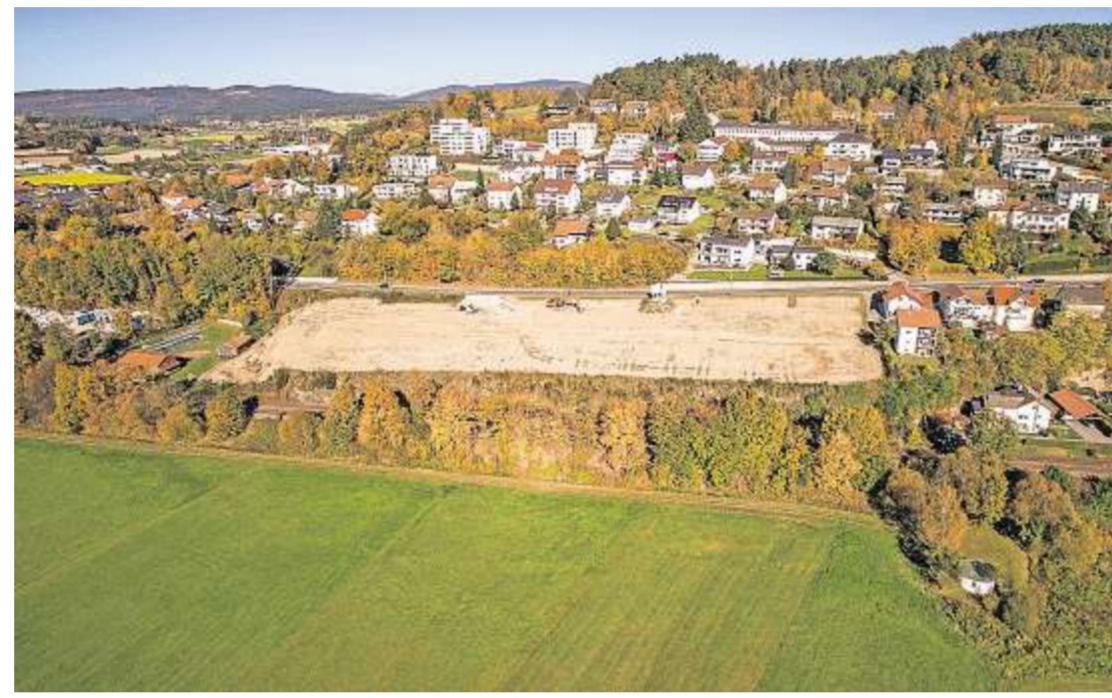
Das Gelände ist bereit für die Bauarbeiten.
