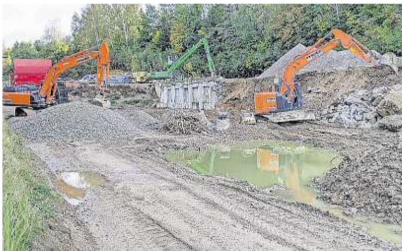
Bagger-Ballett fürs neue Quartier: Große Erdbewegungen schaffen die Basis für die Bebauung durch Gewerbe- und Wohnimmobilien. FOTO: HIENDLMAIER
