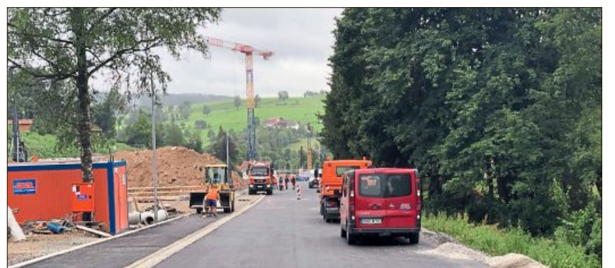
In der vergangenen Woche hat die Firma Rädlinger die Tragschicht an der Westumgehung aufgebracht.
