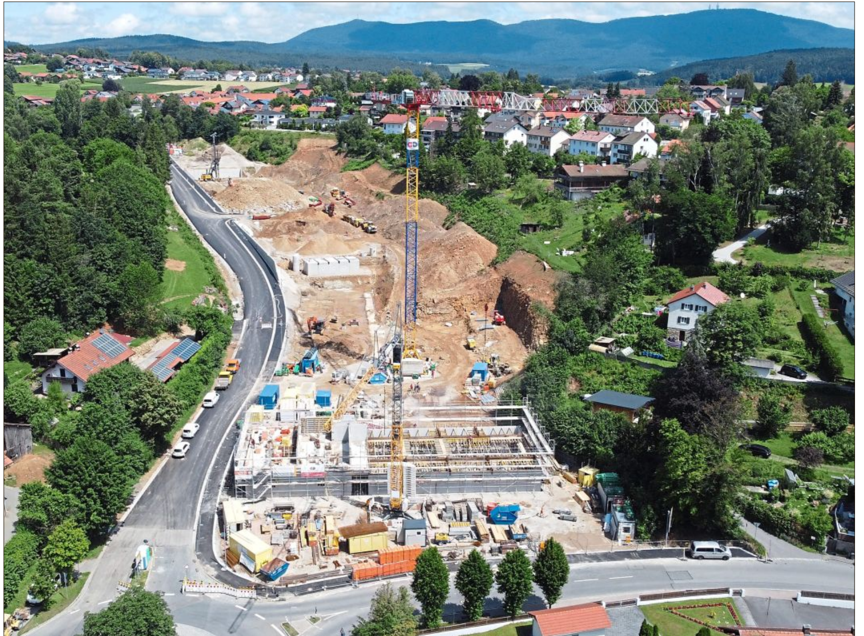
Die Großbaustelle an der Westumgehung in Bad Kötzting. Im August ist die Verkehrsfreigabe der Staatsstraße geplant.
