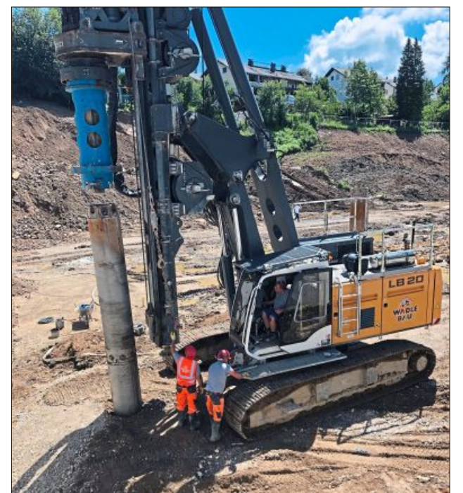
Mit dem Ramm- und Bohrgerät werden Betonpfähle im Boden versenkt.
