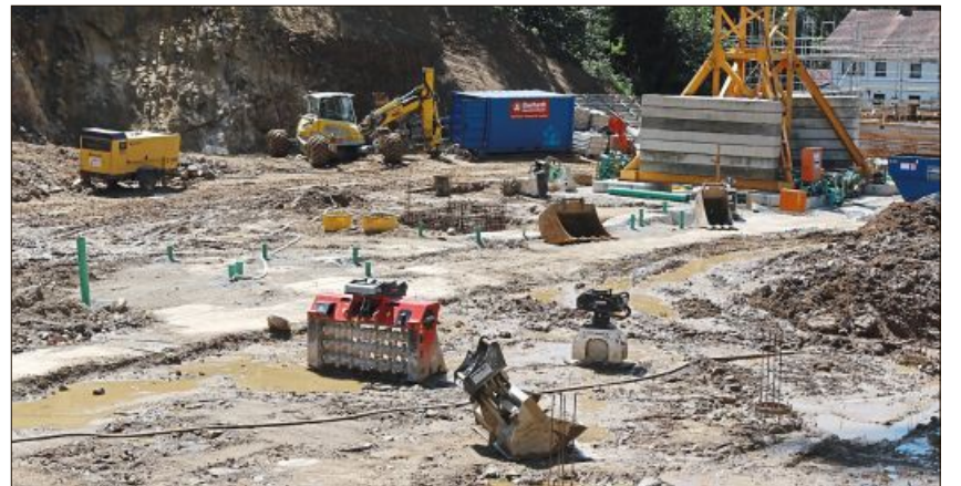
Es „rockt“ auf der Baustelle Westumgehung. Verschiedene Firmen arbeiten Hand in Hand.
