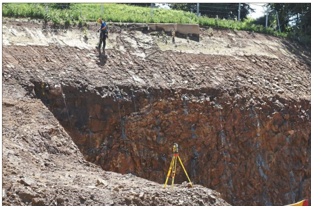
Am Felsabhang, der von der Platte her abgegraben werden muss, montieren Berufskletterer Befestigungen für die Stahlnetze. Sie dienen der Sicherung der Böschung.
