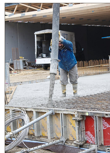
Ein Arbeiter verteilt Beton über die Bodenplatte.
