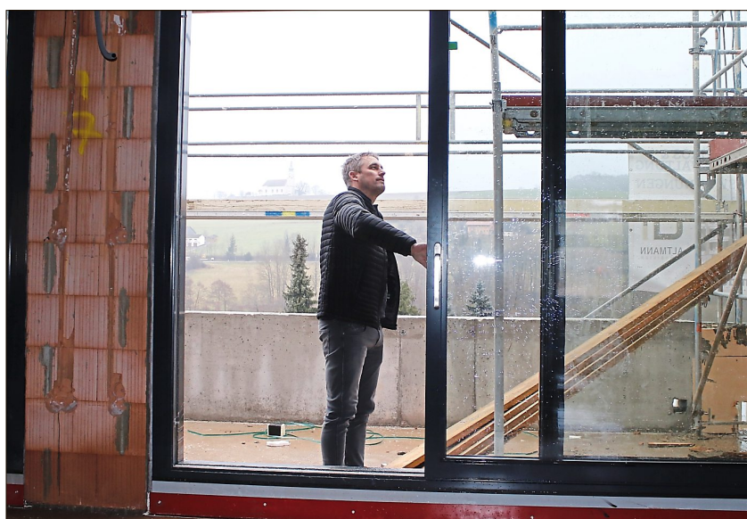
Matthias Altmann geht durch das Wohn- und Geschäftshaus „Weißer Regen“ und kontrolliert die Türen und Fenster.
