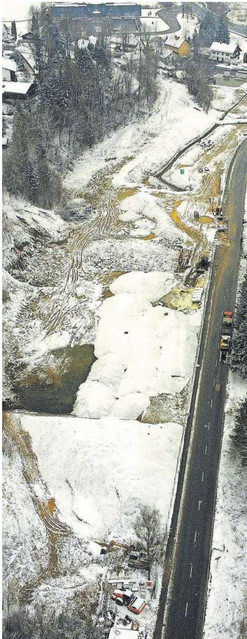
So sah die Großbaustelle auf dem ehemaligen Aschenbrenner-Areal Anfang des Jahres aus. Mittlerweile ist die Straße komplett erneuert und das erste Wohngebäude steht bereits.
