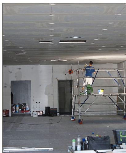
Handwerker bauen die Abhangdecke im Aldi-Markt ein.
