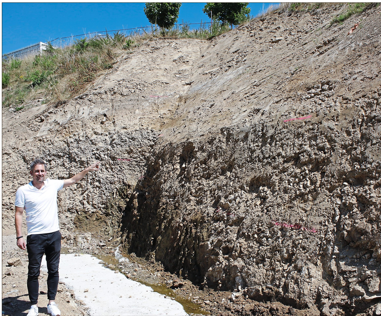
Matthias Altmann steht auf der Unterkante der Kellerbodenplatte. Darauf kommen noch drei Meter Tiefgarage und darauf wird das Erdgeschoss des Wohngebäudes gebaut. Hinterher wird das Gelände wieder verfüllt. Fotos: Wolfgang Reimer
