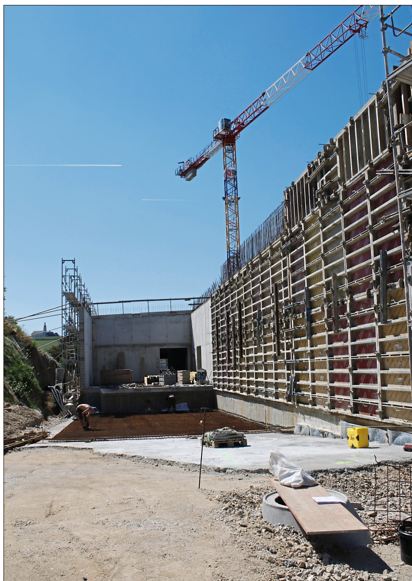
Der dreigeschossige Edeka soll voraussichtlich bis März eröffnen, links im Bild die Lieferzufahrt.
