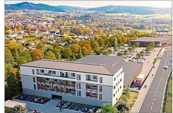
Läuft: Für den nördlichen Wohnblock wird am Fundament gearbeitet. Er soll im Frühjahr 2024 bezugsfertig sein. Foto: Grafik Altmann
