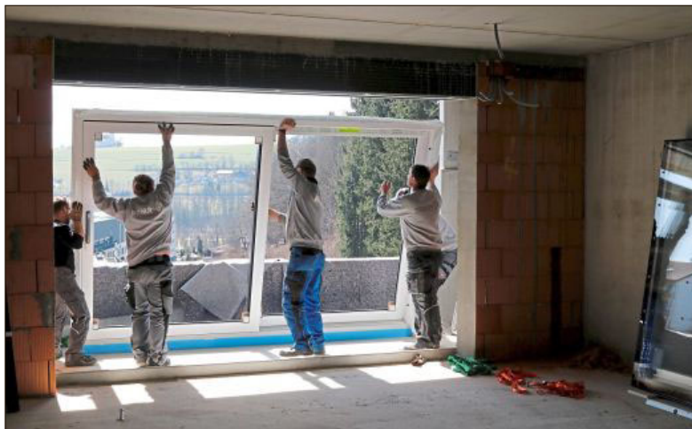
Schwerstarbeit: Ein Fenster wird an seine Position gehoben.
